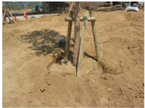
▲改良土への植栽
