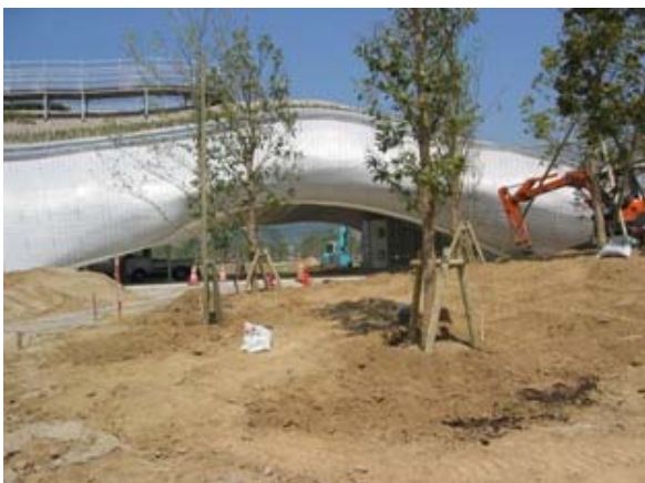
▲改良土への植栽
