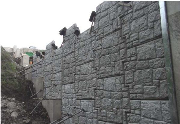
▲テールアルメ外観
