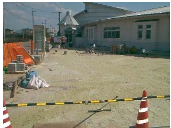
▲透水性ブロック施工
