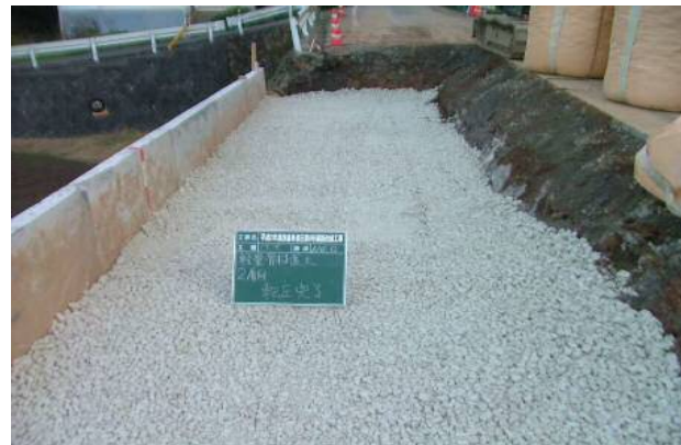
L型擁壁埋戻し(軟弱地盤の為、上載荷重の軽減)
