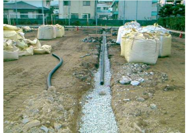
屋外体育施設の水はけ(グラウンドの暗渠排水)
