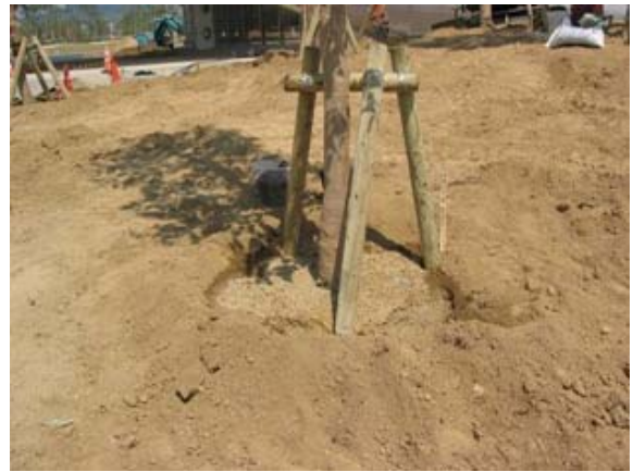
▲改良土への植栽
