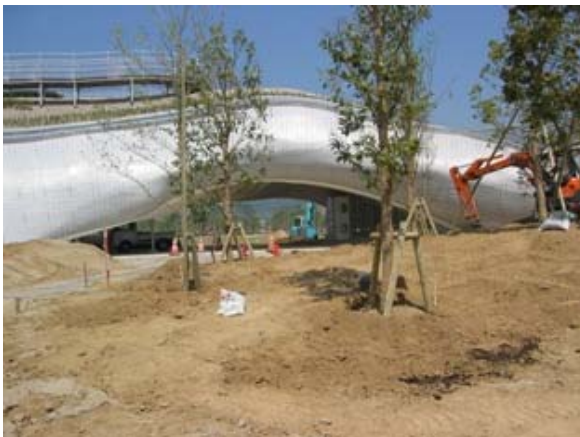
▲改良土への植栽
