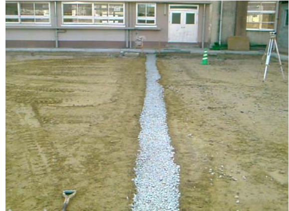
▲配水管埋設後
